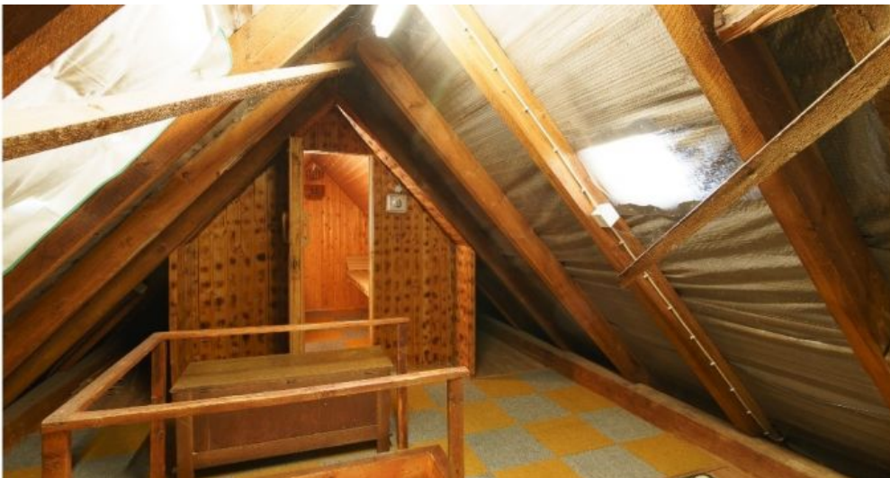
Dachboden mit Sauna
